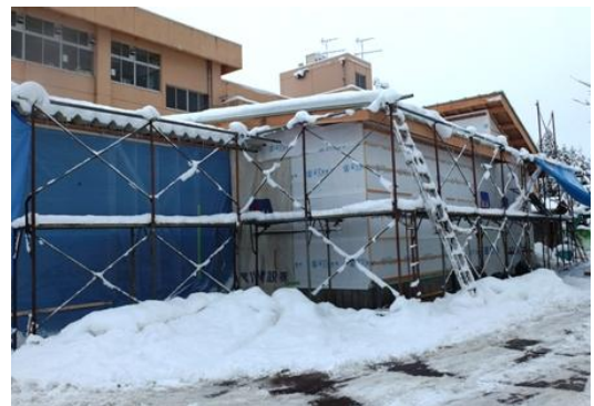
外壁工事も始まりました 《12.25.撮影》
