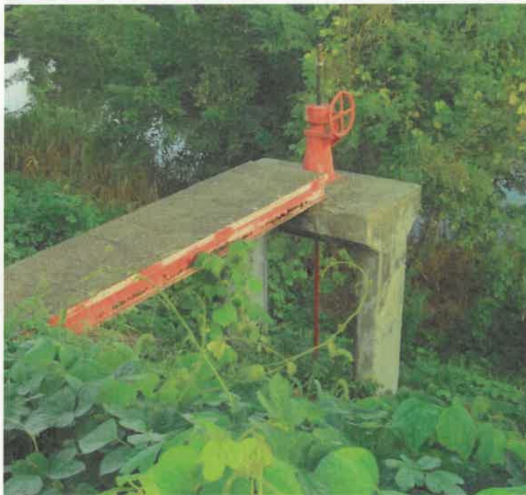
漆山地内? 樋門
