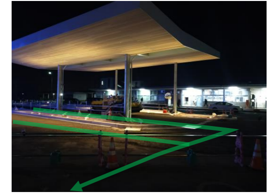
降車専用レーンに設置された上屋の夜間の様子
