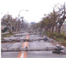
台風で電柱が倒れ通行止め
