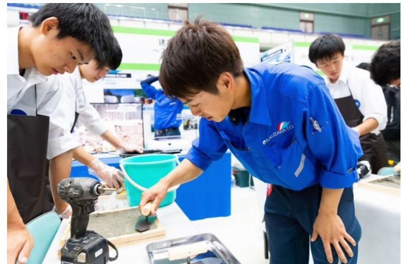
▼コンクリート仕上げ体験（建設会社）
