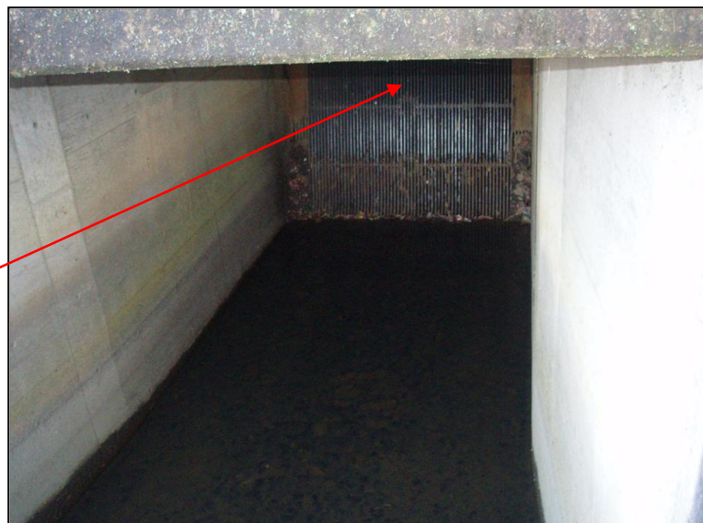
葛巻雨水ポンプ場
