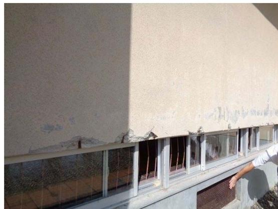
体育館外壁 コンクリート爆裂による鉄筋露出
