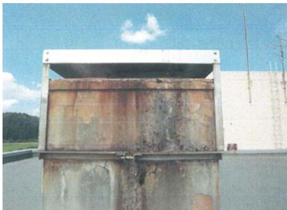
特別教室棟屋上 煙突コンクリート劣化・損傷
