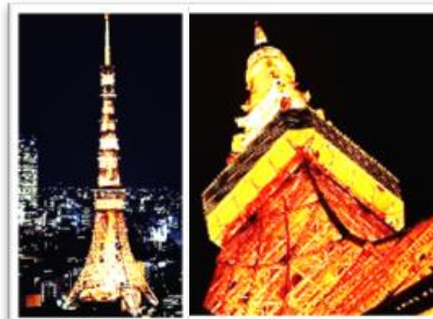
東京タワー：地下に巨大な土台
