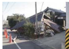
▲市内で多くの家屋が倒壊
