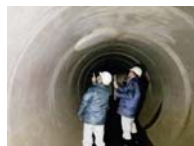
雨水貯留管点検の様子
