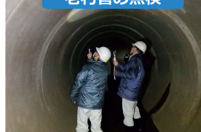
老朽管の点検
