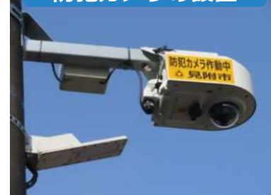
防犯カメラの設置
