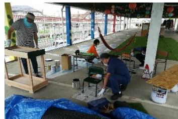
←9/19黒板塗料を塗る作業
