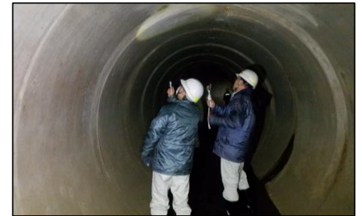
▲R7年2月 下水道管緊急点検
