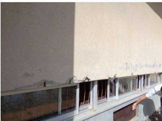
コンクリート爆裂により鉄筋が露出した体育館外壁
