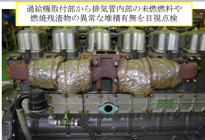
図2 排気管内部目視点検
