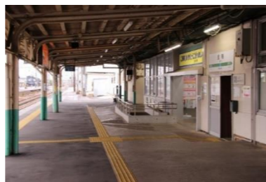
駅舎とホーム上屋の状況
