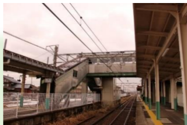
見附駅の既存跨線橋
