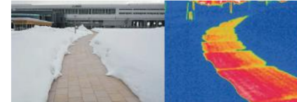
地中熱融雪システムの導入事例（上越妙高駅）
