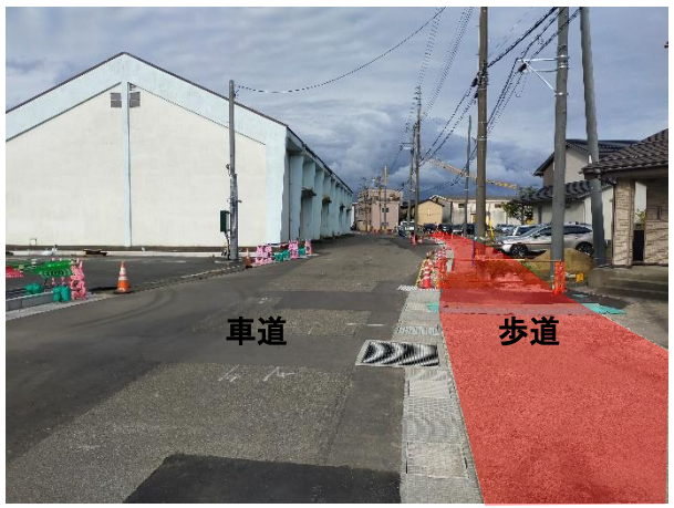
写真① 整備が進む歩道工事
