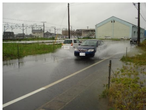
過去の豪雨により浸水した道路の様子
