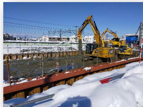
雨水貯留槽の工事状況(1月上旬)
