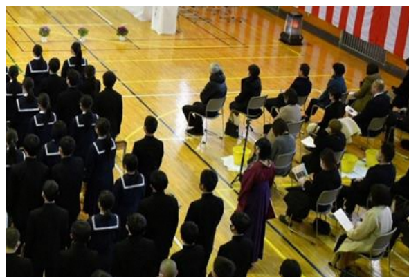
卒業式で雨漏りしている体育館
