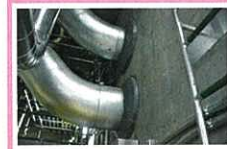
+ 配管貫通部 止水処理
