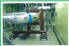
配管等の支えを追加
