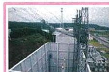
+ 送電線を所内へ引き込む部分の耐震強化
