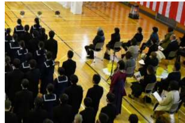
今町中 体育館 卒業式で雨漏り。バケ ツで対応。
