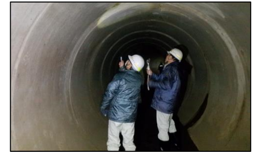
▲R7年2月 下水道管緊急点検
