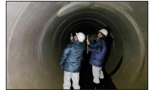
▲R7年2月 下水道管緊急点検
