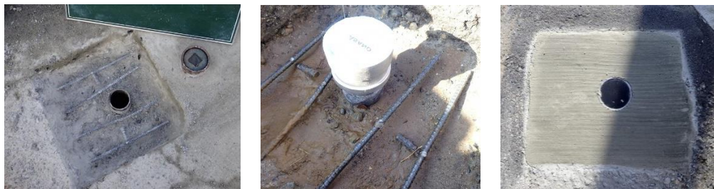
写真 3-3 ドレーン交換写真例
