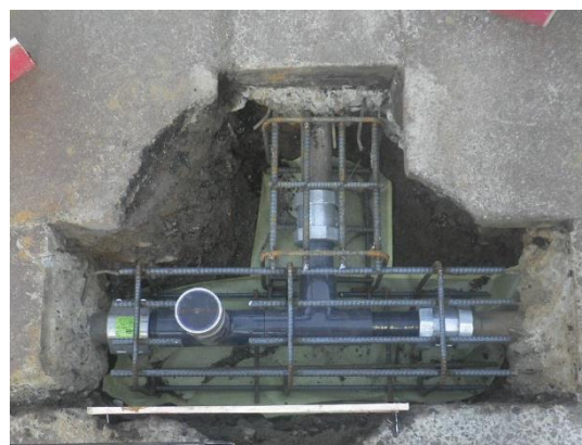
写真 3-5 配管洗浄完了後（左：清掃完了後の配管、右：配管復旧例※打設前）
