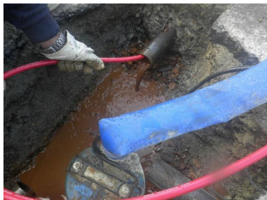
写真 3-4 配管洗浄作業状況（左：清掃作業全景、右：清掃作業近景）
