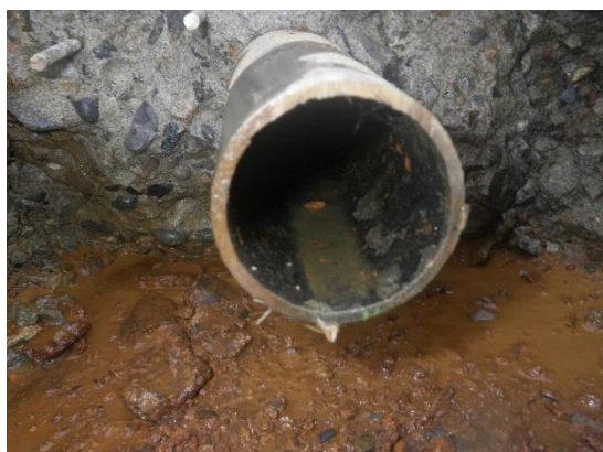
写真 3-5 配管洗浄完了後（左：清掃完了後の配管、右：配管復旧例※打設前）
