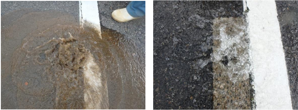
写真 2-4 排泥状況の例（左：排泥開始時、右：排泥完了時）
