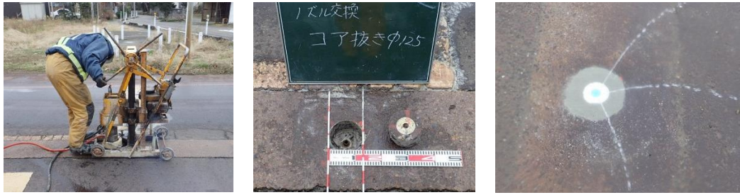
写真 3-2 ノズル交換写真例
