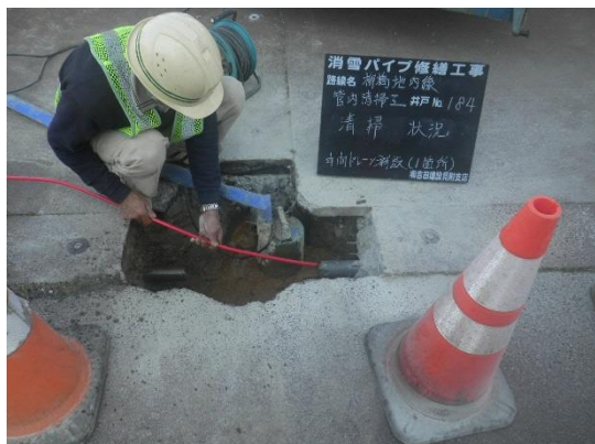
写真 3-4 配管洗浄作業状況（左：清掃作業全景、右：清掃作業近景）
