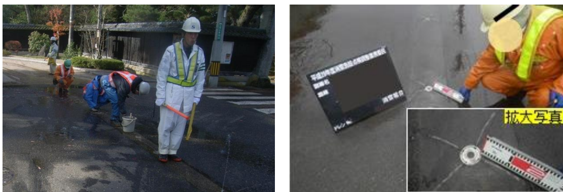
写真 2-7 ノズル調整状況（左：調整作業、右：散水距離確認）
