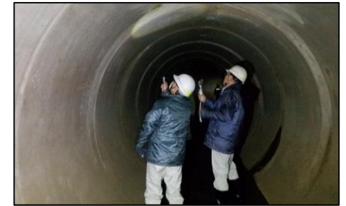
▲R7年2月 下水道管緊急点検
