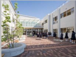
屋上、屋根、外壁 (部位改修では優先的に改修)
