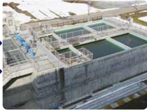
沈砂池・原水調整池 川の水を貯めて、大きな汚れを洗めて水質の安定化を行います。
