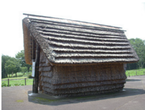
写真 2-1 藤橋遺跡（新潟県長岡市） 掘立柱建物復元
