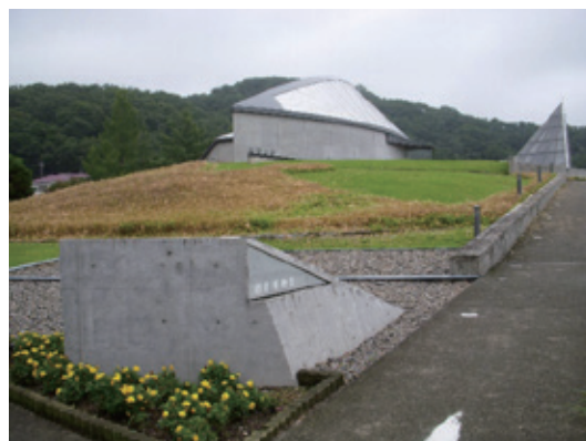
写真 5-11. 岩宿遺跡 (群馬県みどり市) コンクリート打ち放しに石の名盤貼込
