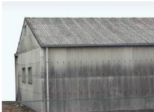
石綿含有スレート波板（屋根・外壁）
