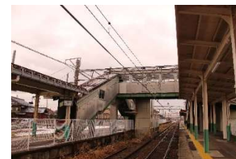
既存跨線橋の外観状況
