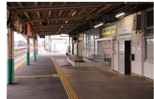
駅舎とホーム上屋の状況
