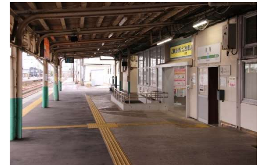
駅舎とホーム上屋の状況
