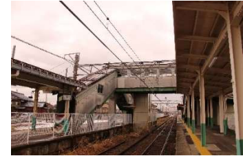
既存跨線橋の外観状況
