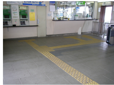
点字ブロック
