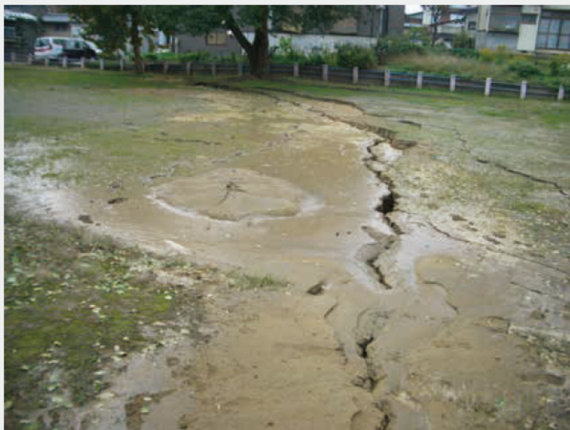
公園のクラックと噴砂丘 [新潟県中越地震（平成16年）]
