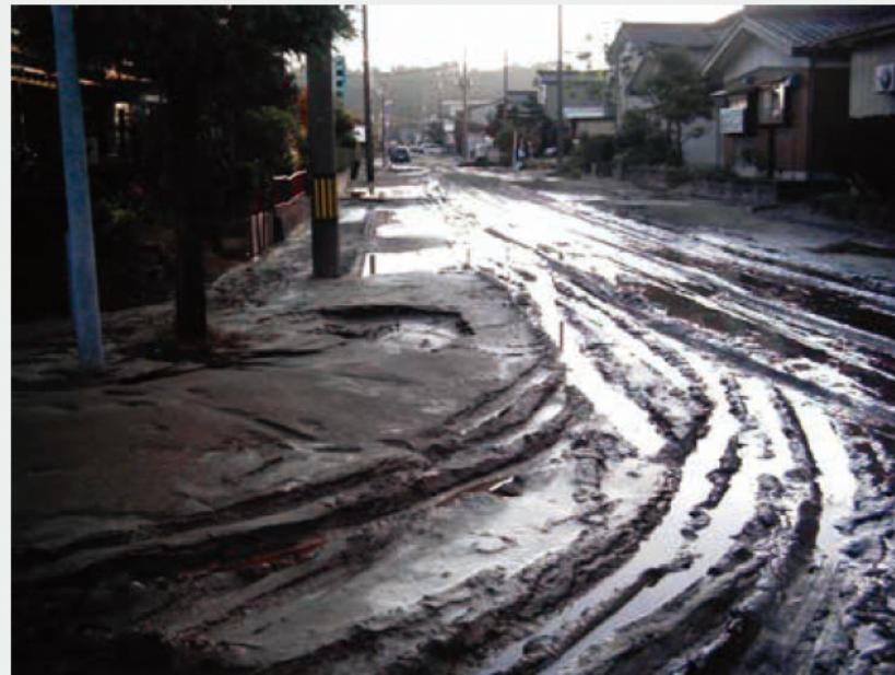
液状化による噴砂 [新潟県中越地震（平成16年）]
