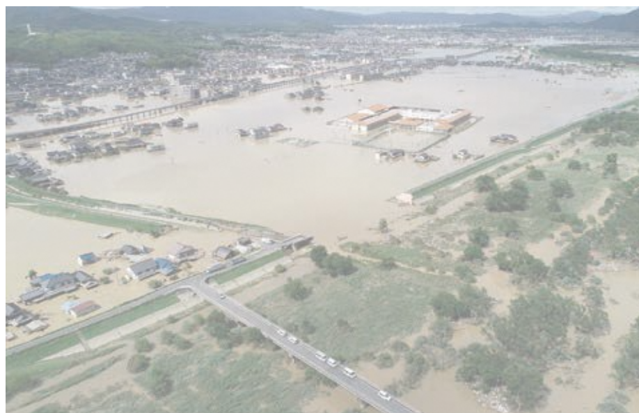
平成 30 年 7 月豪雨における岡山県倉敷市真備町の浸水の様子 (写真提供：国土交通省中国地方整備局)
