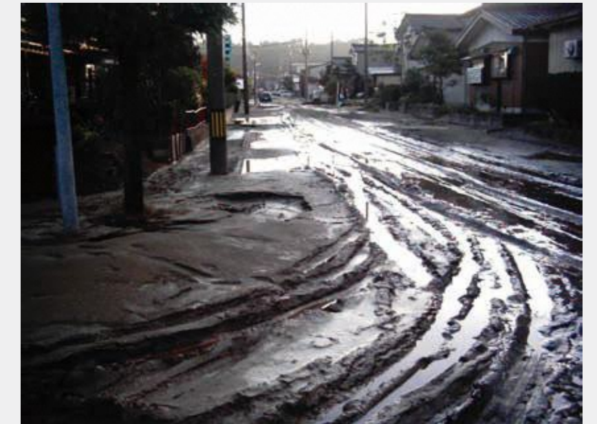
液状化による噴砂 [新潟県中越地震(平成16年)]
