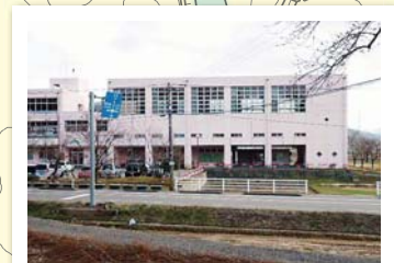
北谷南部地区ふるさとセンター
