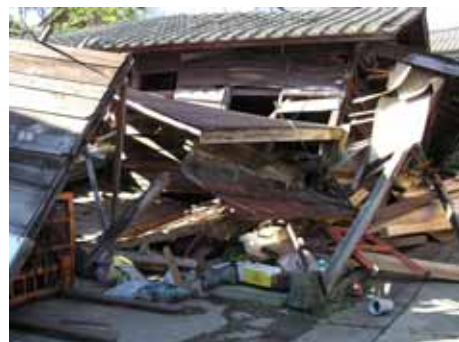
新潟県中越地震の被害
