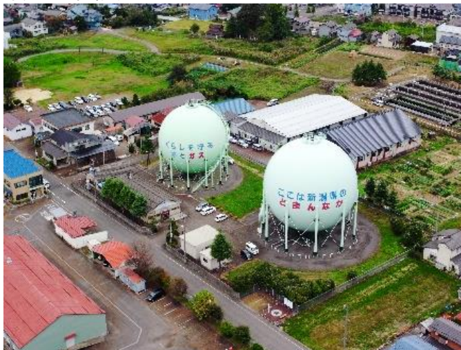
中央ガス供給所
